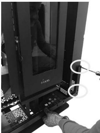
Fig. 35 - Στερέωση κάτω βραχίονα
