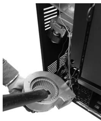
Fig. 71 - Καθαρισμός ανεμιστήρα περιβάλλοντος
